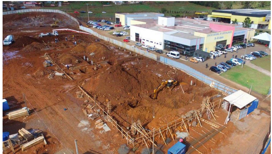
A Construtora Sudoeste está construindo o Hospital Geral Intermunicipal no Bairro Água Branca. A conclusão da obra deve ocorrer num prazo de 24 meses. O hospital vai atender os 27 municípios da microrregião. Fotos: Assessoria
